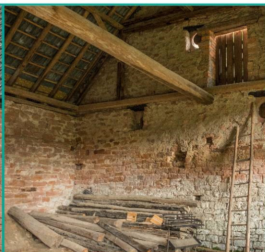
Innenansicht der Scheune
