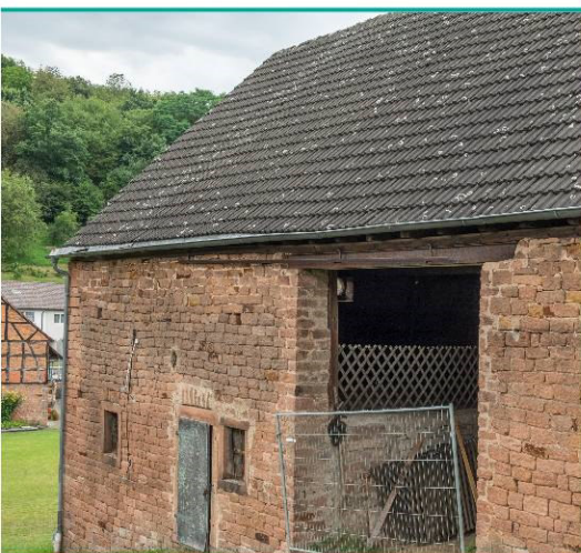
Außenansicht der Scheune
