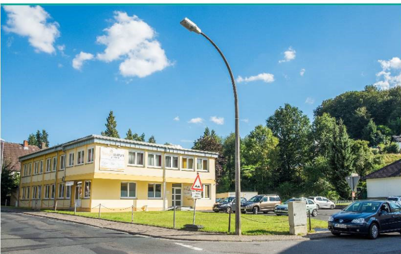
Der verrohrte Roßbach am Therapiezentrum
