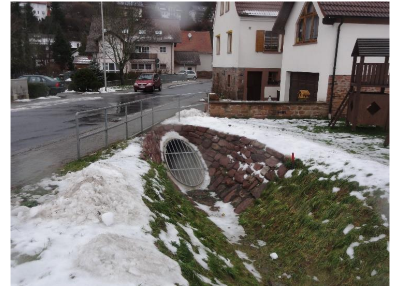
Einlauf Verrohrung Schöntalgraben, Foto: BGS Wasser
